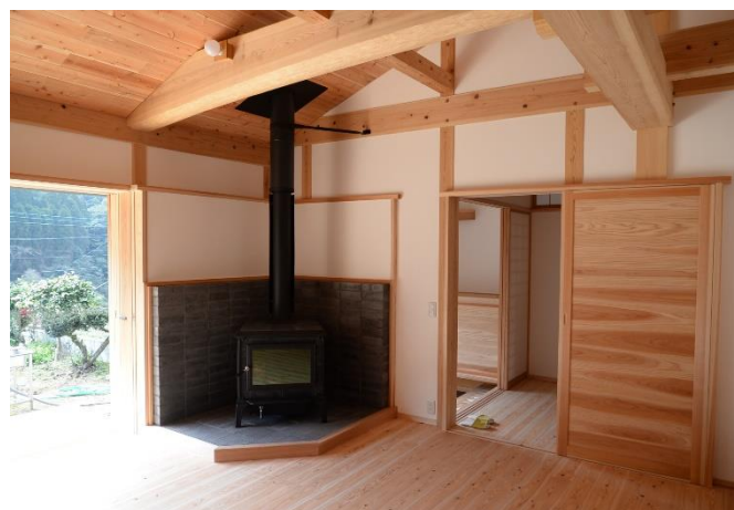
施主が所有する山から産出した材を使った構造材
