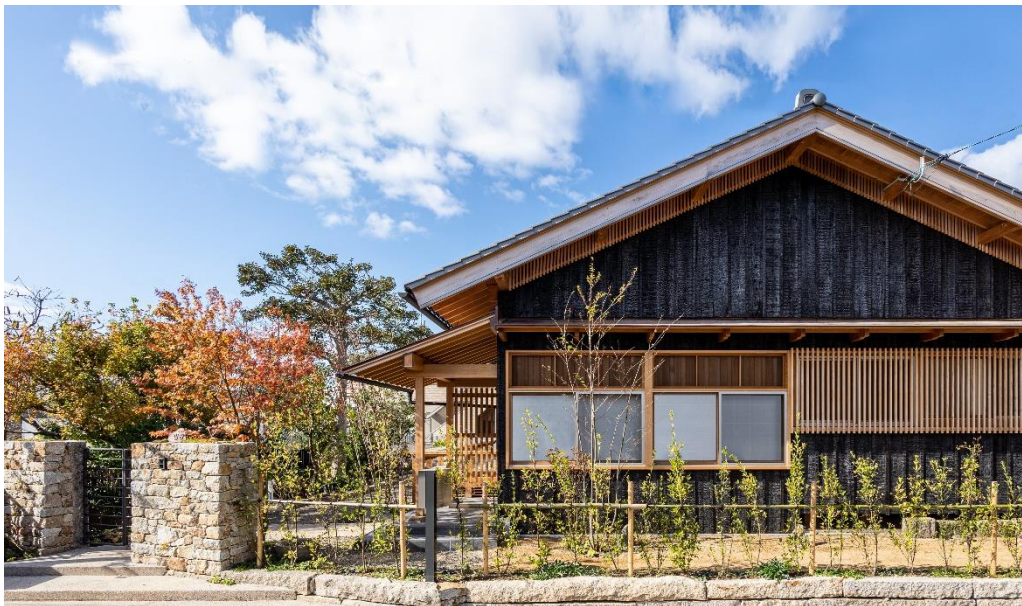
地域の景観に溶け込むよう外壁に焼杉を用いた外観
