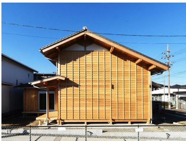
杉板の鎧下見板張り（箆子仕様）の外観
