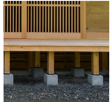
開放的な床下（石場建て）
