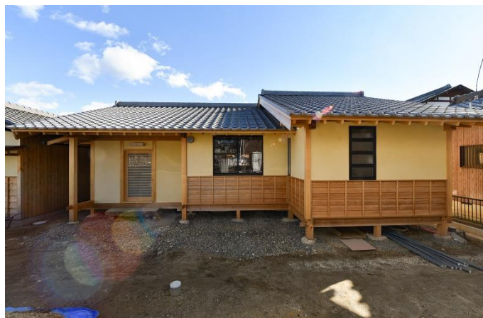
稲わらを使った土壁と板壁で構成されたシンプルな外観
