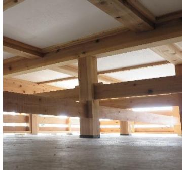
開放的な床下（石場建て）
