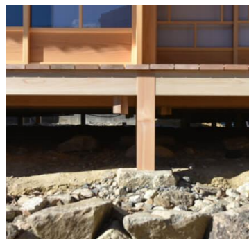
開放的な床下（石場建て）
