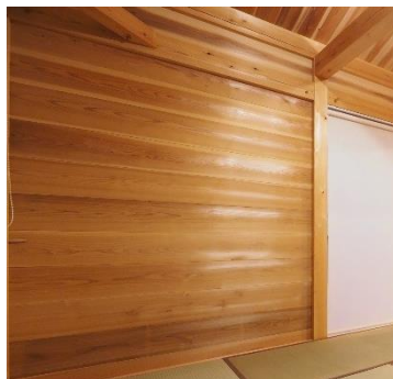
板壁（落とし込み板壁等）
