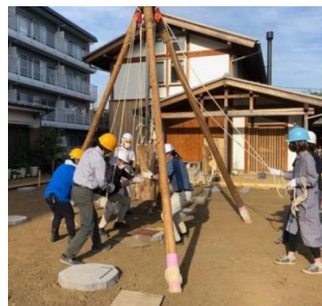
開放的な床下（石場建て）
