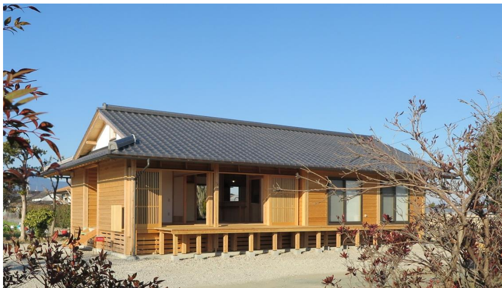
地域の景観と調和した入母屋根の外観
