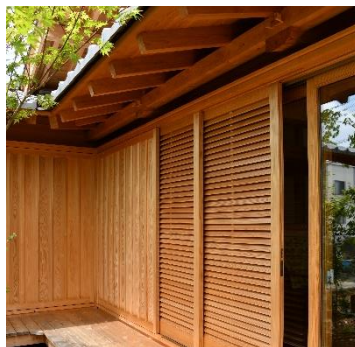
深い軒・庇と多層構成の建具
