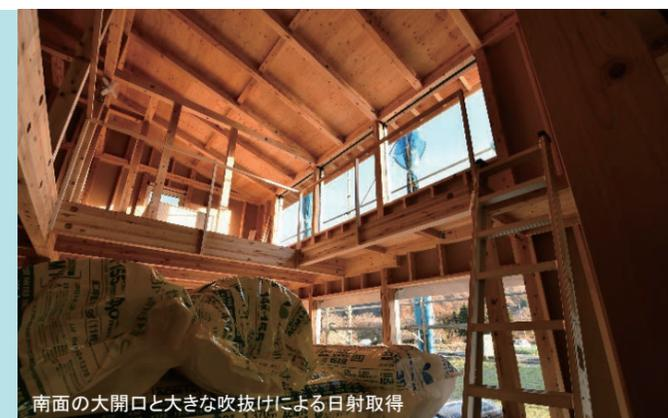
南面の大開口と大きな吹抜けによる日射取得
