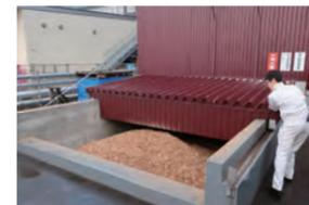
○木質チップボイラーは2週間おきに清掃を行っており、作業のために2時間ほど停止し冷却する。そのバックアップとしてガスボイラーを2基設置。チップサイロが凍結したり、チップに薪が混入してスライドがストップした際にも、自動でバックアップのガスボイラーに切り替わる制御が行われる。
