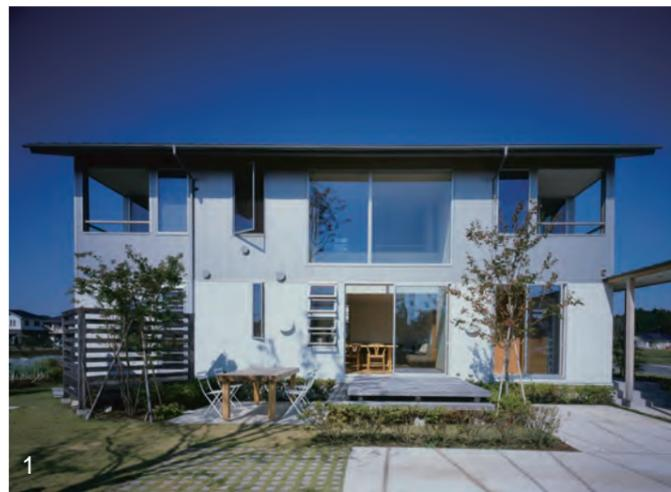
となっている。アトリエには北からの光を取り入れる大きな高窓も設置されている。この家には内と外を結ぶ多様なインターフェイスがつけられている。東の景観緑地に面した和室の縁台は、月見台の見立て、南向きの居間では屋外のデッキを介して庭に繋がる吹き抜けの大きな開口部が設置され、浴室の前にも小さなバスコートが設けられている。西向きの軒下の空間は畑に出るための農作業場となっている。この住宅を構成する標準的なディテールは決まっいて、茨城県南木造住宅センターのシステムを用いて作られている。
