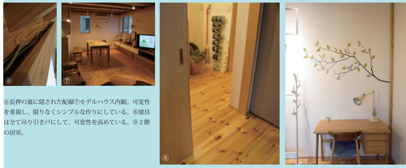
⑥長押の裏に隠された配線⑦モデルハウス内観。可変性を重視し、限りなくシンプルな作りになっている。⑧建具は全て吊り引き戸にして、可変性を高めている。⑨2階の居室。
