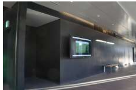
黒漆喰で仕上げられた壁面
