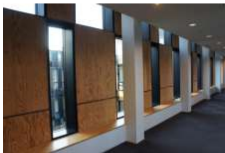
耐震パネルと耐火被覆された木造の柱
