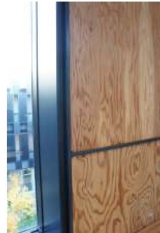
木製パネルと鉄 枠で構成された 耐震パネル
