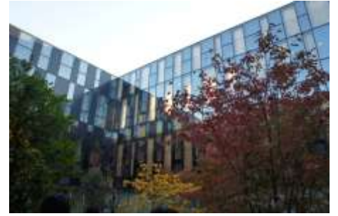
中庭から見た耐震パネル
