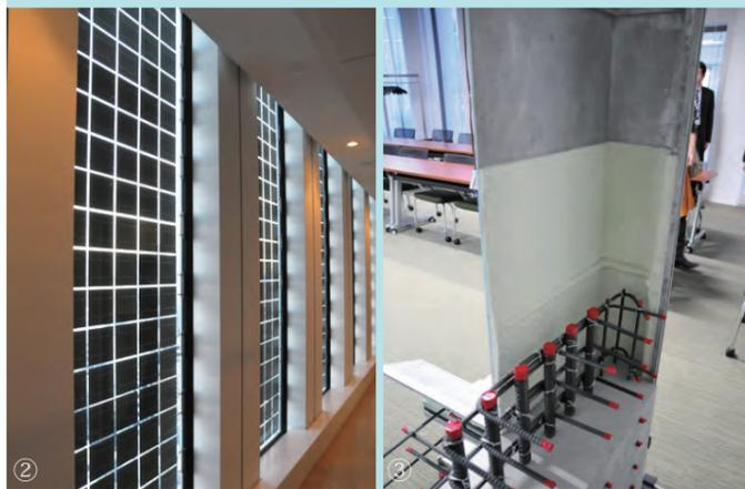
①新本社の外観（東側）。ハイブリッド外装は、耐震、熱負荷軽減、発電の 3 つの機能を果たしている。②開口部の一部に組み込まれた太陽光発電パネル。新本社内の LED 照明の年間エネルギー量を賄える量の発電が見込まれている。③プレキャストコンクリート（PC）一体型アルミキャスト。建物の長寿命化を図るため、ひび割れに強い超高強度コンクリートが採用された。新本社社屋は震災時の帰宅困難者受け入れる地域の防災拠点としての役割も担うため、特に耐震・免震機能が高い建物になっている。
