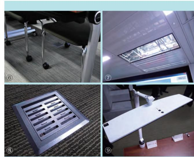
⑥社員の机の下には「パーソナル床吹出し口（⑧拡大写真）」が設けられており、微妙な温度調整が個人の判断で可能となる。⑦天井には輻射パネルが設けられている。体への負担や室内の温度ムラが少ない。⑧パーソナル床吹出し口の拡大。しくみはかなり単純なもので、無窓を靴裏で開閉しながら個人の好みの空調を調節できる。⑨個人用の卓上 LED スタンド。明るさも 3 段階調整できる。⑩ハイブリッド型輻射パネル。輻射パネルを室内に光を取り入れやすい形状に取り付け、照明への使用電力を削減する。
