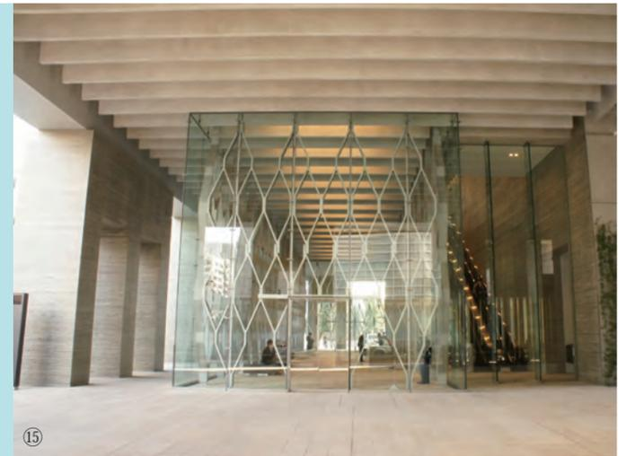
⑮木の柱に排煙ダクトを組み込んだことで、空間を仕切らずに分煙が可能となった。木の呼吸と排気を一つのイメージとして設計されている。新設された宝町駅出口のすぐ横に位置するため、多くの人が利用していた。⑮エントランス部分のアルミキャスト。外装パネルに用いられたものと同様の素材で、風圧によるたわみを抑える。鋼鉄の縦材（スチールマリオン）とのハイブリッド構成により、1枚の大きさが高さ7.9m、幅2.1mもの大判ガラスを支持している。
