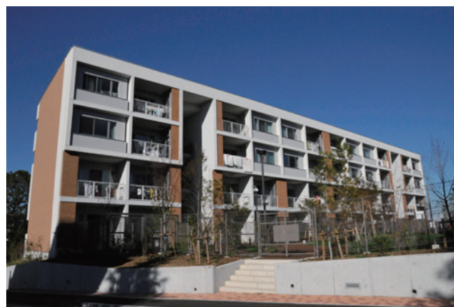
磯子スマートハウス外観
