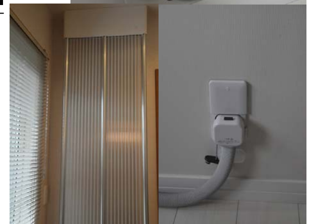
豊富に用意された熱端末機器の例（温水ファンコンベクター（上）、温水パネルヒーター（左下）と温水コンセント（右下）
