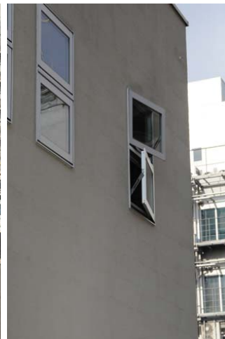
通風に配慮した開口部
