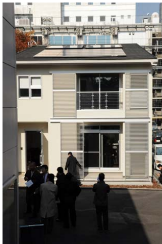
太陽光発電・太陽熱利用施設が搭載された屋根
