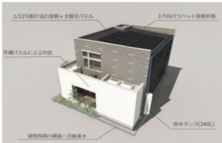
3 方向バラベット屋根+太陽光発電パネル、雨水タンク
