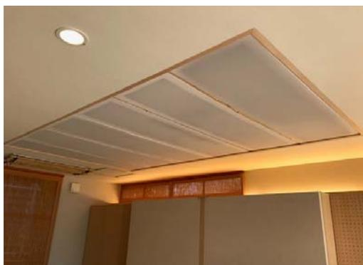
冷風が直接体に当たらず快適な輻射冷房
