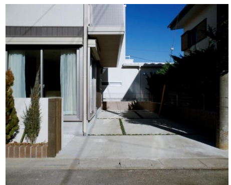
<改修後の駐車場部分>
