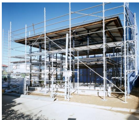
<解体後のスケルトン状態>
