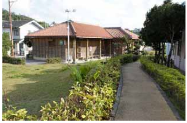
公園にある伝統的な沖縄の工法で建てられた集会所
