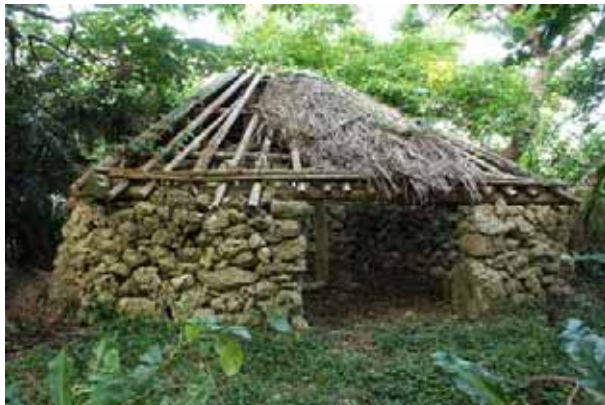
石垣（外壁）に直接屋根を葺いた住まいの原型
