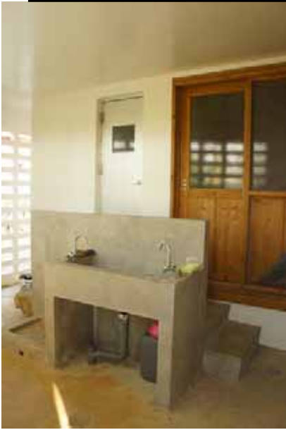
緩衝帯に設置された流し（左のドアは浴室）
