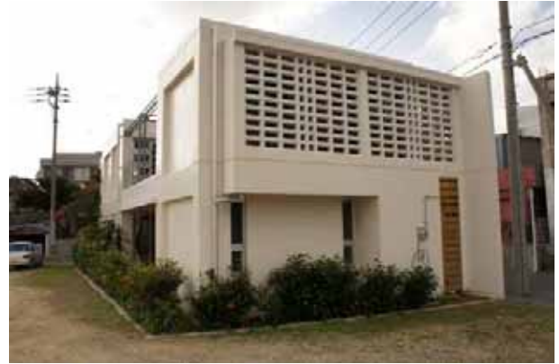
通風に配慮された開口部をもつ北側外観
