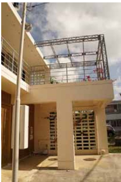
南入りのエントランス周り
