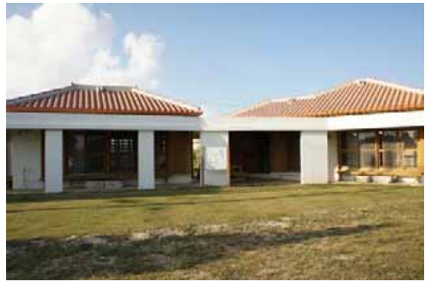
中央の半戶外空間と RC 造の緩衝帯でつながれている
