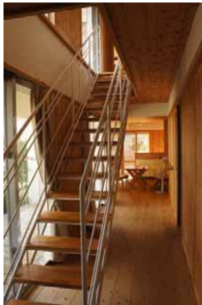
通風に配慮された階段
