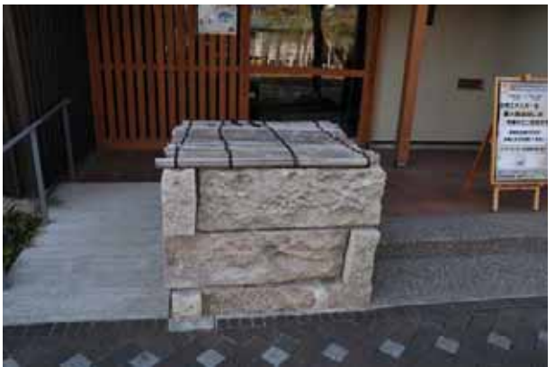
工事中に発見された井戸を雨水貯留として再利用
