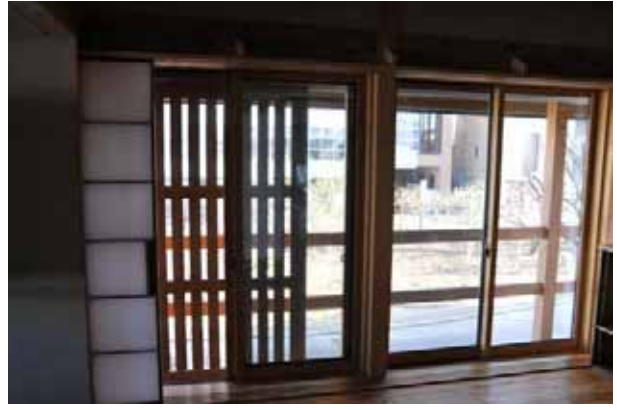
外側の格子戸と内側の断熱障子による日射調整と保温
