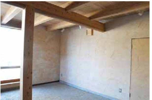
南棟 1 階のシンプルな空間
