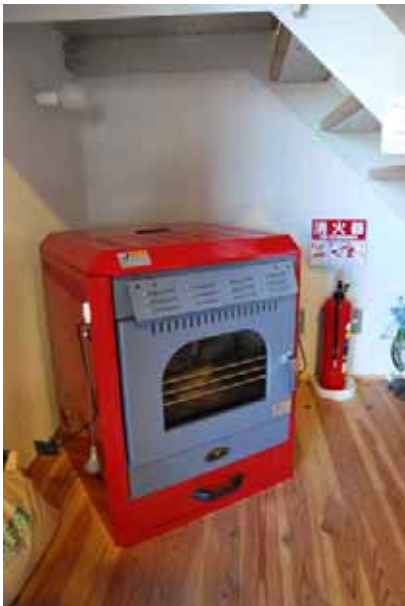
北棟に設置されたペレットストーブ
