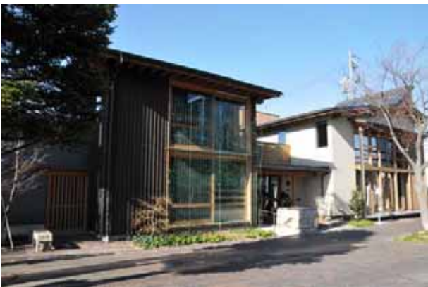
エコハウス外観（南東方向）
