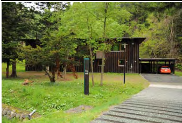
道路からの下川町エコハウス外観
