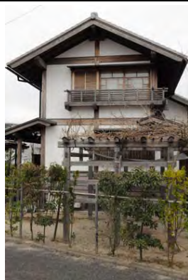
水俣エコハウス外観
