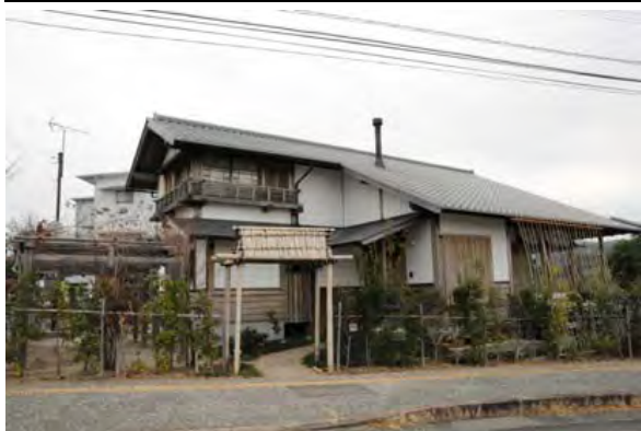
水俣エコハウス外観
