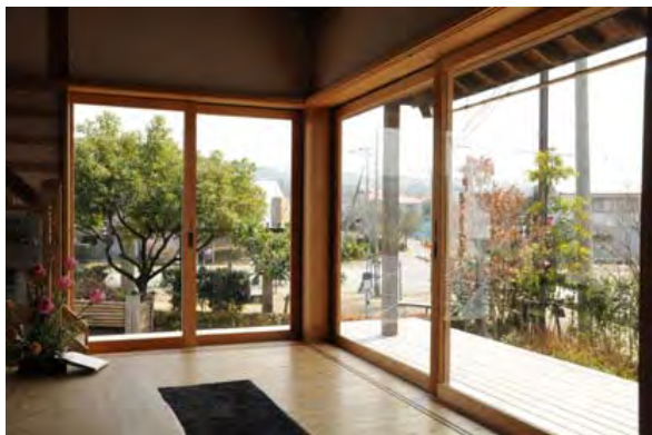
東南の大開口部。ガラスと障子で断熱性を確保している
