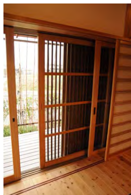
雨戸、ガラス戸、網戸、障子の4層構成の開口部
