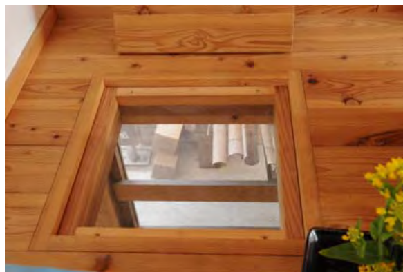
床下からの通風のための開口部
