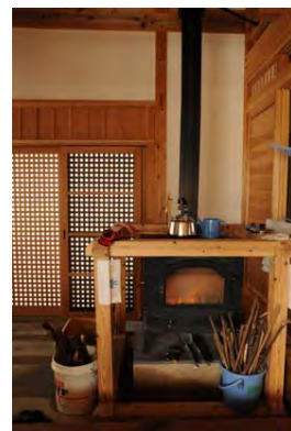
玄関土間に設置された薪ストーブ
