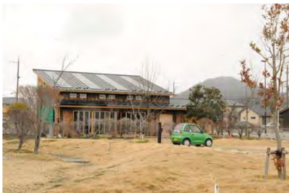
小舟木エコ村の中に建つ近江八幡エコハウスの外観 太陽光発電パネルは縦長にデザインされている
