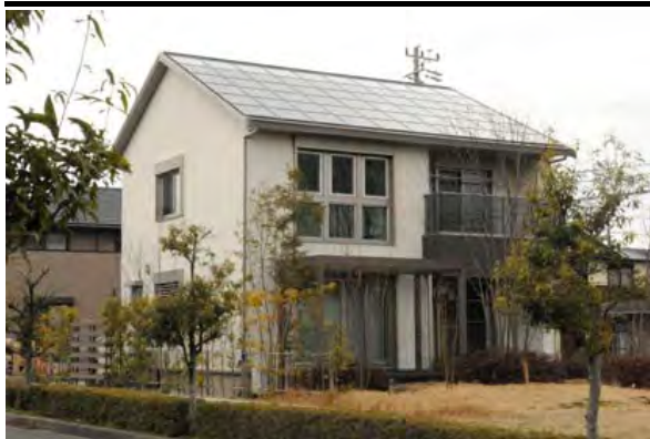
メインストリートからの外観 屋根全面に太陽光発電パネルが設置されている
