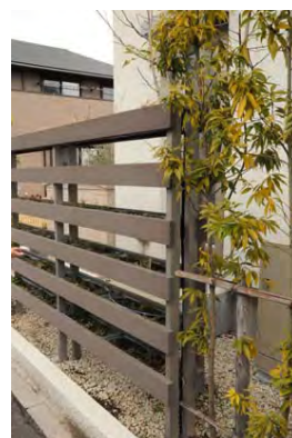
メインストリート沿いに設置 された緑化ルーバー
