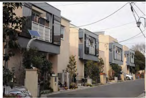
エコウォール（可動式ルーバーと壁面集熱パネル）が個性的なまちなみ景観をつくる「TERA」
