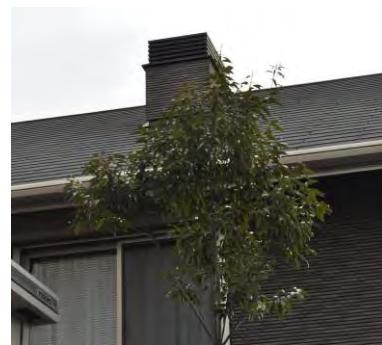
屋根に設けた排気口。温度差を利用した自然換気を促している。
