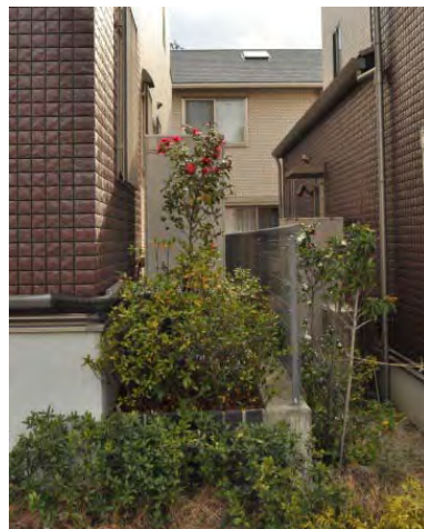
図 3-2-1-5 隣棟間の状況
