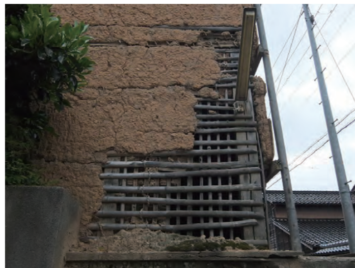
[02] 出石町の土壁。大壁でありわら縄が少ない。
