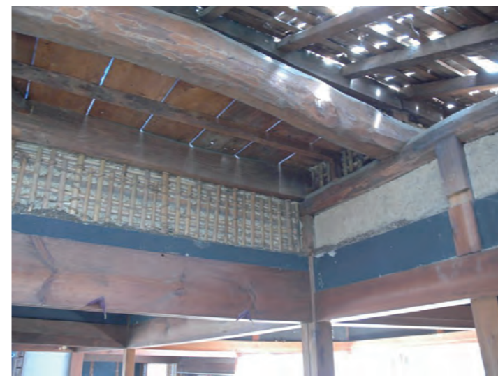
[03] 岐阜の古民家。天井裏は、土を塗らない。
