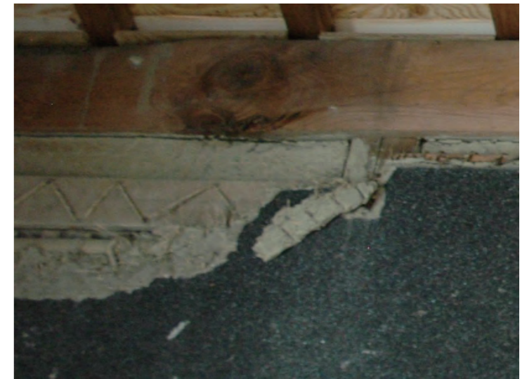
[04] 貫に穴を開けわら縄を編みこんだ事例。
