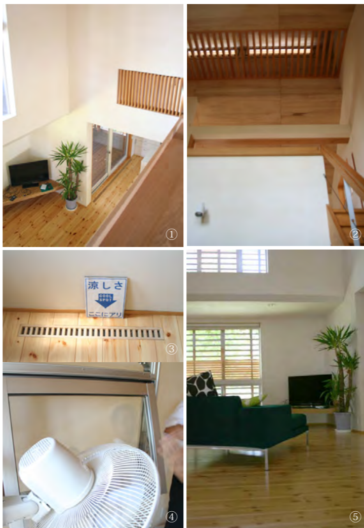
①②吹抜けに設けられた格子状の空気の通り道。上に溜まった暖気を逃がす。屋根は 2 重構造で、天井面からの輻射熱を抑える③ 2 階床下にある冷気口。④風の圧力だけで開閉するパッシブウィンドウ⑤リビング南面。緑のカーテンと木製格子で南からの日差しを防ぐ。「緑風の家」の開口部には、外側に簾や格子が置かれ、室内へ入る日射が徹底的に抑制されている。
