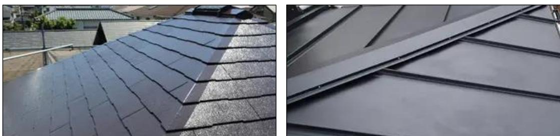
図 2-2 軽い屋根の屋根材の例：化粧スレート（左） 金属板（右）
