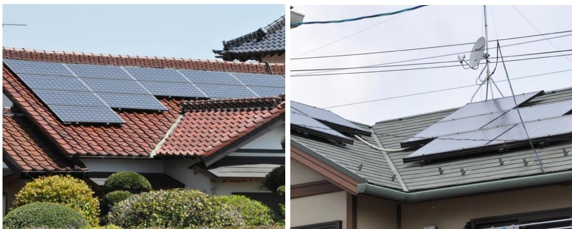
図 4-24 屋根置き型の例
