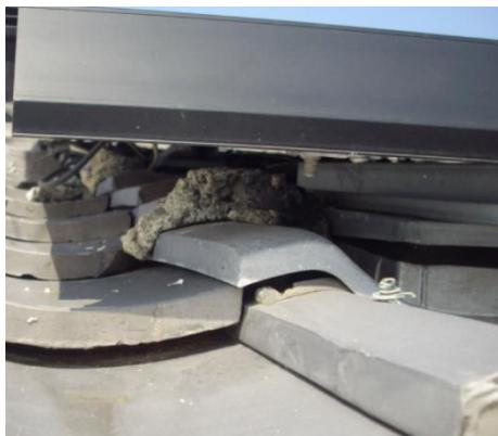
太陽電池モジュールを設置するための支持瓦と周辺瓦の大きさが異なっているため、大きな隙間から瓦内部へ雨水が浸入した例
