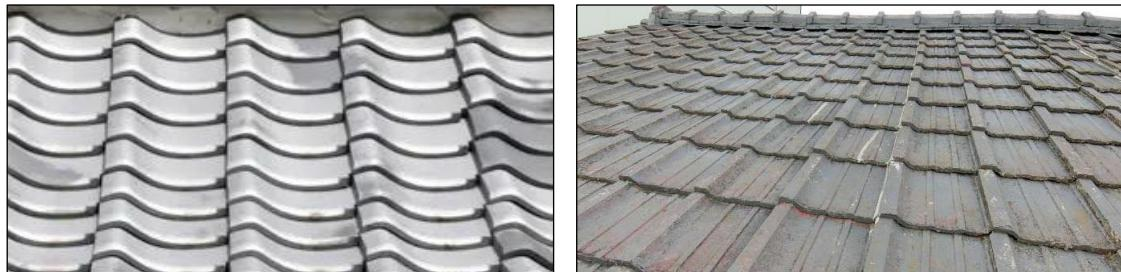
図 2-1 重い屋根の屋根材の例：陶器瓦（左） セメント瓦（右）
