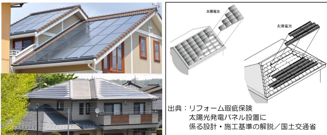
図 4-25 屋根建材型の例
