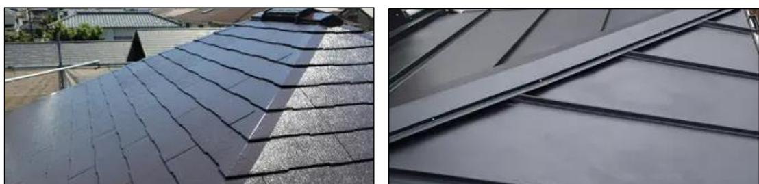
図4-2 軽い屋根の屋根材の例：化粧スレート（左） 金属板（右）
