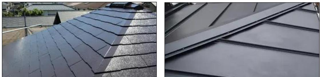
図3-2 軽い屋根の屋根材の例：化粧スレート（左） 金属板（右）
