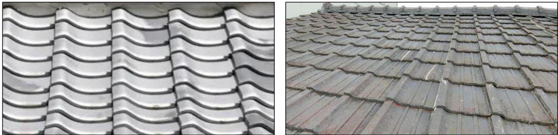
図3-1 重い屋根の屋根材の例：陶器瓦（左） セメント瓦（右）
