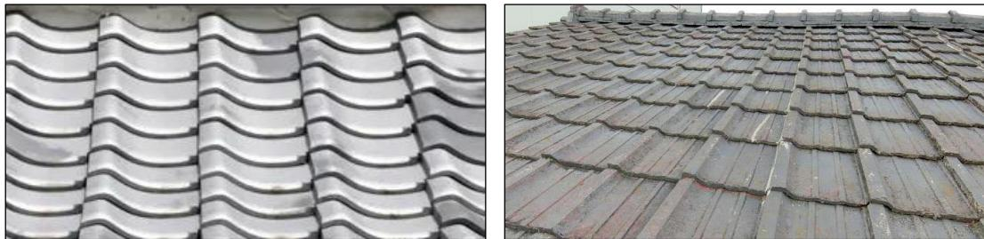
図4-1 重い屋根の屋根材の例：陶器瓦（左） セメント瓦（右）
