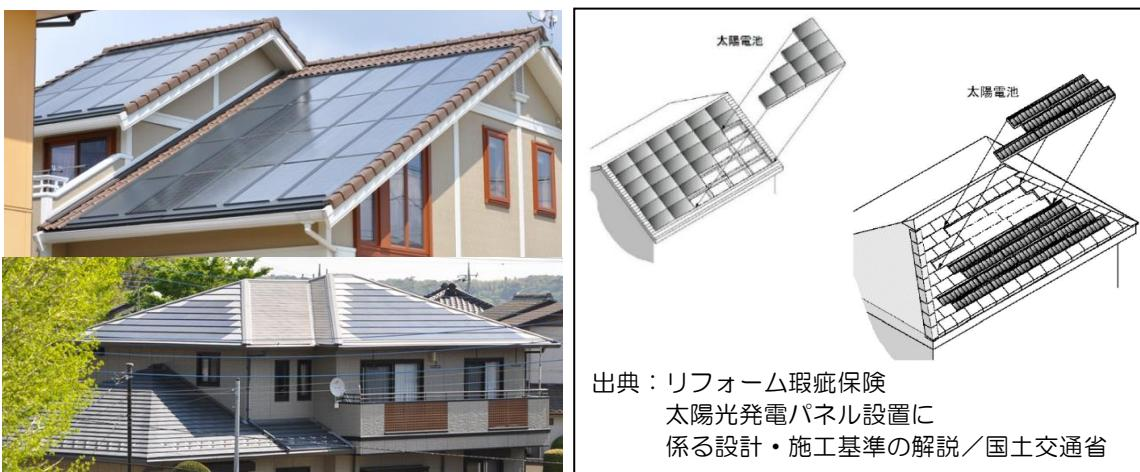
図 2-24 屋根建材型の例
