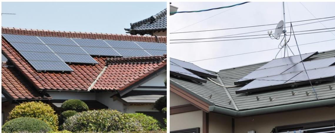
図 3-18 屋根置き型の例
