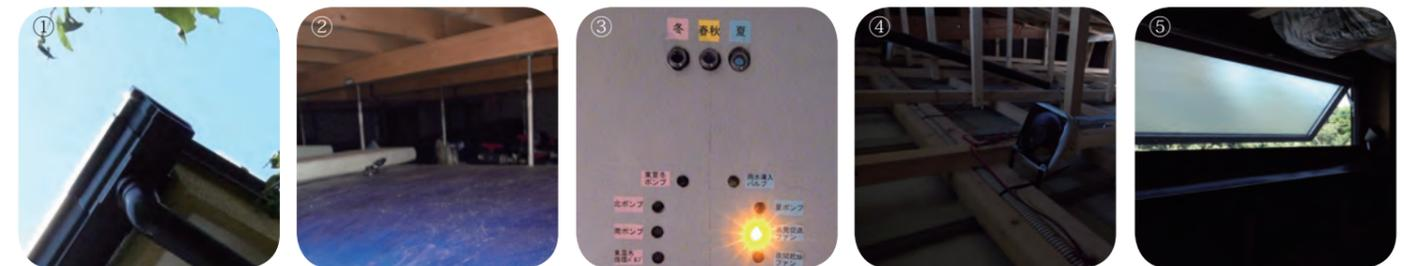
ろ過フィルター付軒樋で雨水とごみを分離し、効率的に集水する。床下放熱タンクに雨水を流入するのは夏のみで、冬はビオトープ用水流として利用する。
