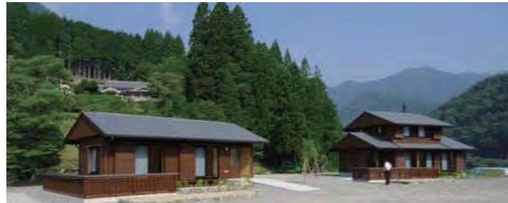
十津川村復興モデル住宅 /スバルノフキオロシ、板壁、生垣、板塀、野面石、菜園
