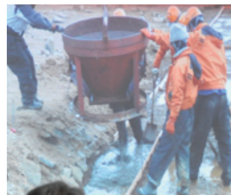
建設作業の様子
