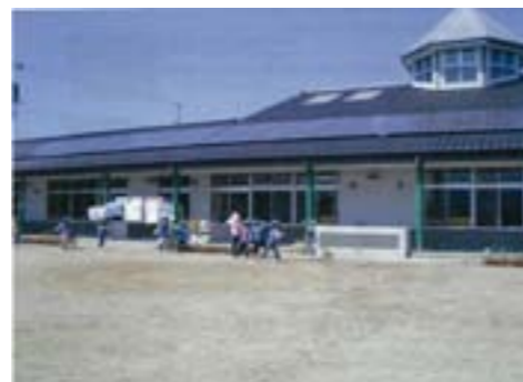
長野県飯田市 おひさま進歩エネルギーの一例（幼稚園の屋根に設置された太陽光パネル）
