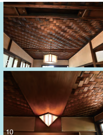
6. 連窓で開放的な縁側空間 7. 柱のない角の窓 8. 気密性の工夫が施された窓枠 9. 導気口を組み込んだ網代天井 10. 客室の天井と照明 11. 藤井氏のデザインによる椅子と机 12. 客室に設えられた床の間 13. 緑豊かな外構と南側の落葉樹 14. 軽快な屋根
