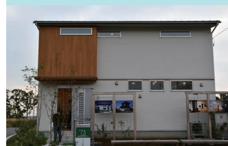
通風に配慮した横長の開口部が並ぶ外観
