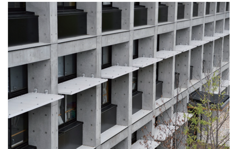
窓の外に設けられたライトシェルフ
