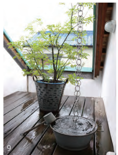
1. 野川沿いの緑道。2. キッチン窓からの眺め。庭の緑が目にも優しい。春になると野川のしだれ桜も見える。3. 手回しタイプのペレットストーブは日本製。停電時でも着火できる。4. 夏から冬の太陽高度を計算して設計された南側の軒。これにより夏季の冷房負荷が大幅に削減されている。5. キッチンとダイニングの間の壁の上部は抜けているので、視線を遮ることなく空間を広く見せている。6. 床材にも使用した足場材の再生材を使った玄関ドア。7. プライベート用とは別に、仕事用の玄関と水場（ミニキッチンとトイレ）を設けたことで、公私の境界が明確になった。8. 浴室窓からの眺め。9. 浴室外の木デッキ。雨どいの先に雨水桶を設けた。
