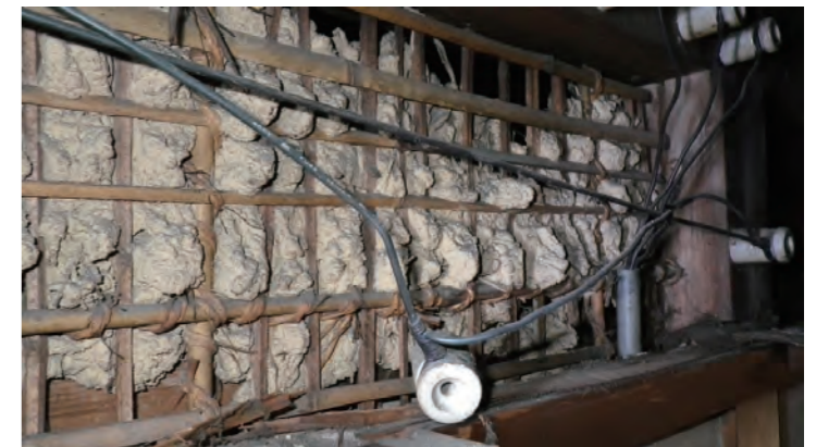
[05] 片面土塗り。縦竹面から塗っている。
